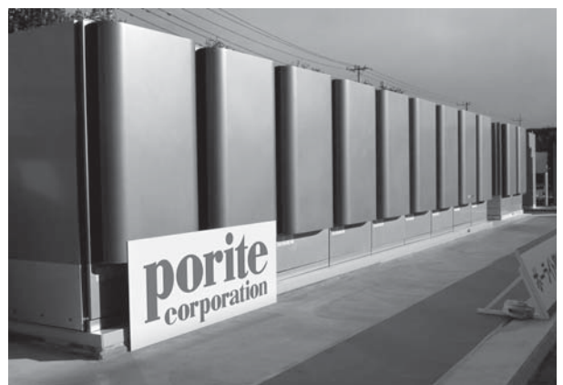
ポライトに導入された「エネルギーサーバー」
