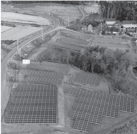
コアフィールズの太陽光発電所 (同社提供)
