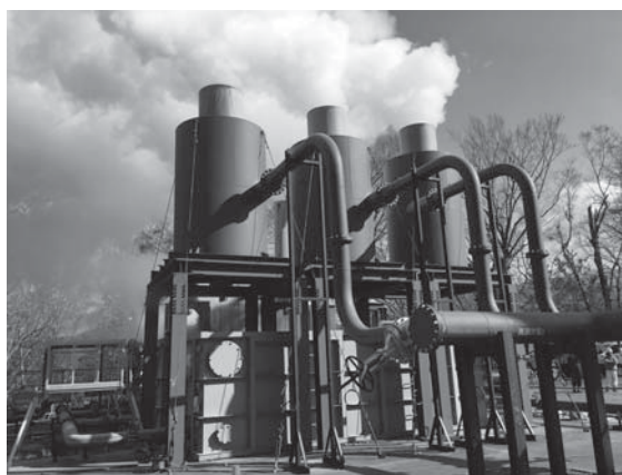
秋田での仮噴気試験の様子(国際石油開発帝石提供)
