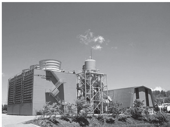
大沼地熱発電所
