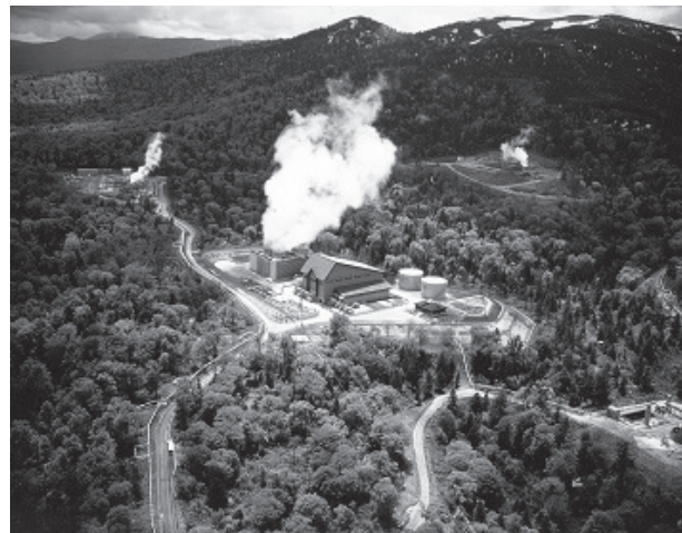
湯川地熱発電所(写真は東北電力提供)
