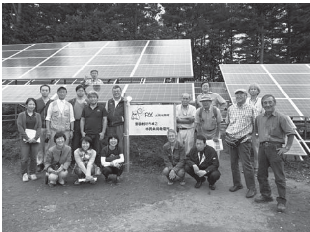
東日本大震災の支援活動として岩手県に建設した野田村だらすこ市民共同発電所 (PV-Net提供)
