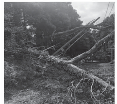
倒木による電柱倒壊(四街道市)
