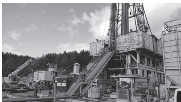
鬼首地熱リブレース工事における現場での生産井掘削の様子
