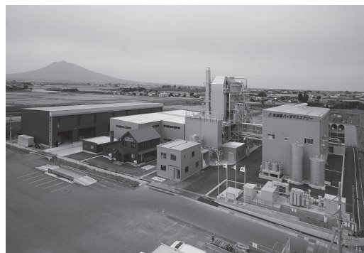
津軽バイオマスエネルギー平川発電所
