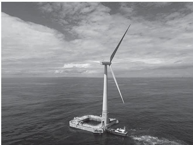
BWイデオルのダンピングプール技術による浮体式洋上風力発電設備(同社の資料より写真引用)
