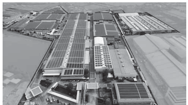
ジェイテクト(タイランド)の工場屋上に設置された太陽光パネル (同社の発表資料より)
